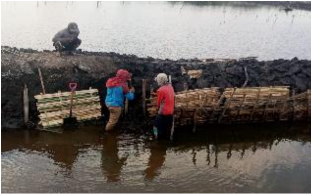
修復したあぜ道の崩壊が再度発生しないよう、竹を使用した壁を用いてあぜ道の補強を行っています。
