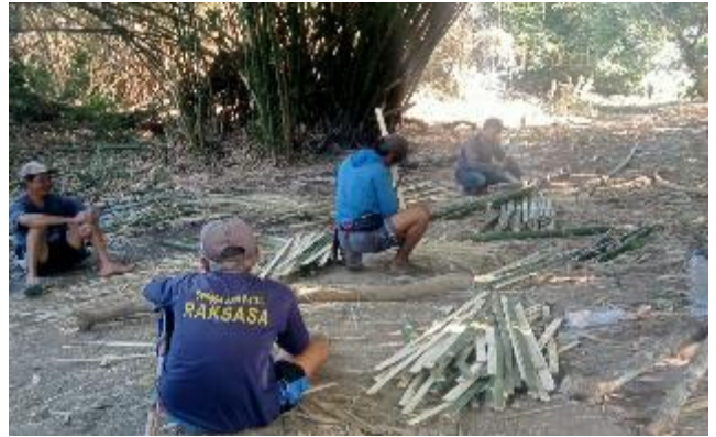
竹を用いた壁の作成時の写真です。
