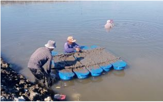
あぜ道の修復に使用する土を採取しています。
